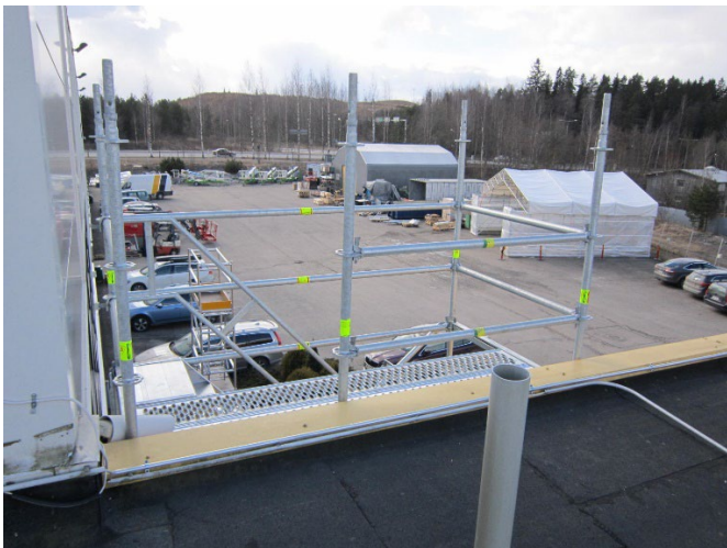
15. Kuvassa voi nähdä kuinka tässä tapauksessa 3. ritilätasolta (6m) poistutaan katolle. Poistumiestie on tässä tapauksessa pitkällä sivulla.
