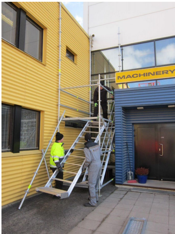
7. Tässä kuvassa tasot ovat jo paikallaan, sekä vaakajuoksut, että vaakajokat. Myös 4,0m korkeuteen on laitettu päätysivulle lyhyt U-jokka, johon voidaan laittaa seuraava porrasmous yläpää.
