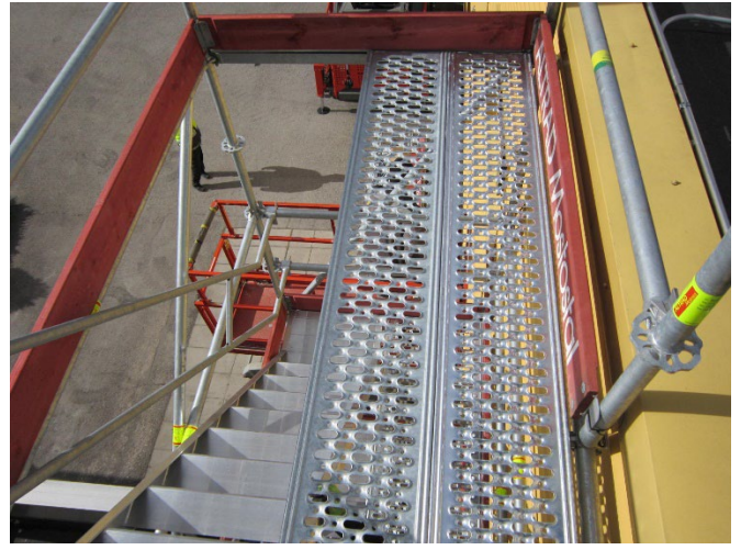
20. Poistumistie sivulle jalkalistojen asennus
