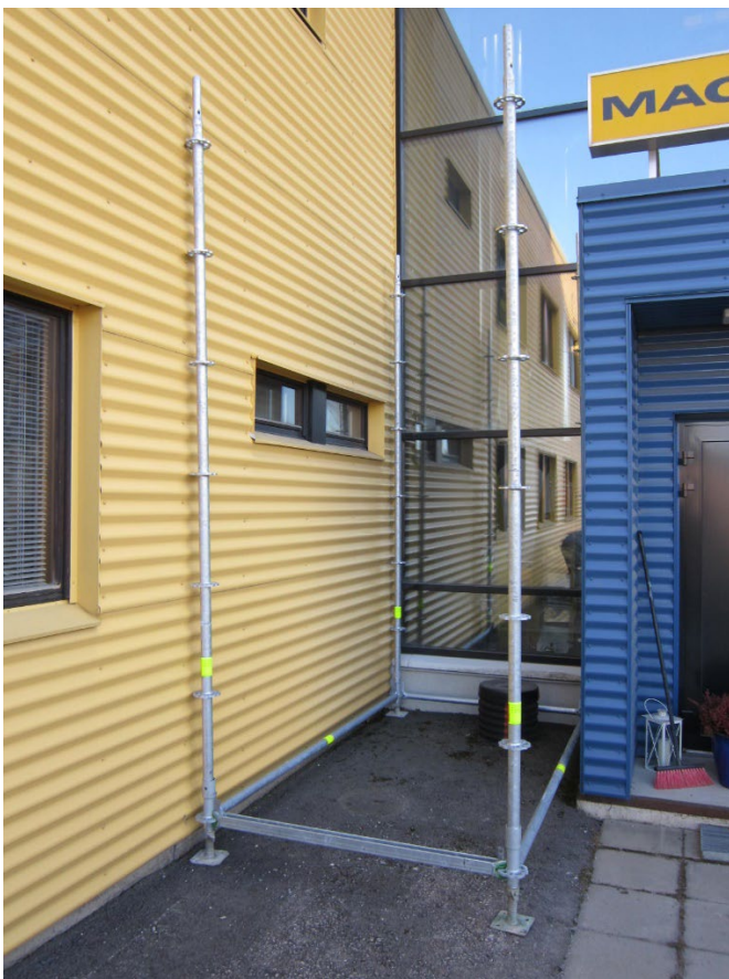
3. 3,0m pystyputkien asennus
