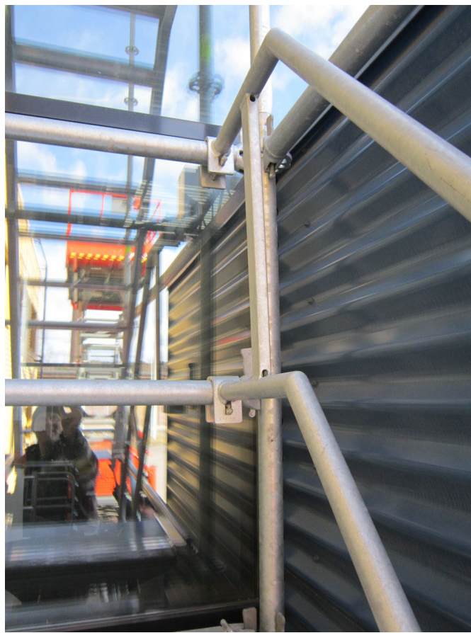
10. Tässä kuvassa nähdään, kuinka kaide-elementin yläpää tulee kiinni vaakajokkiin.
