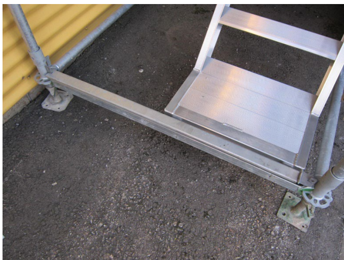
11. Jokaisella tasolla on huolehdittava portaan ja tason kiinnitys tasolukitsimellä, jotta taso tai portas ei pääse ponnahtamaan pois paikaltaan.
