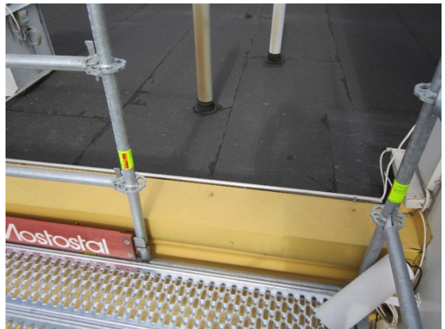
16. Poistumiestie sivulle osia ovat: 1kpl Liitin pystyputkelle 1kpl Pystyputki 1,0m 2kpl O-Vaakajokka 1,57m 1kpl Jalkalista 1,57m
