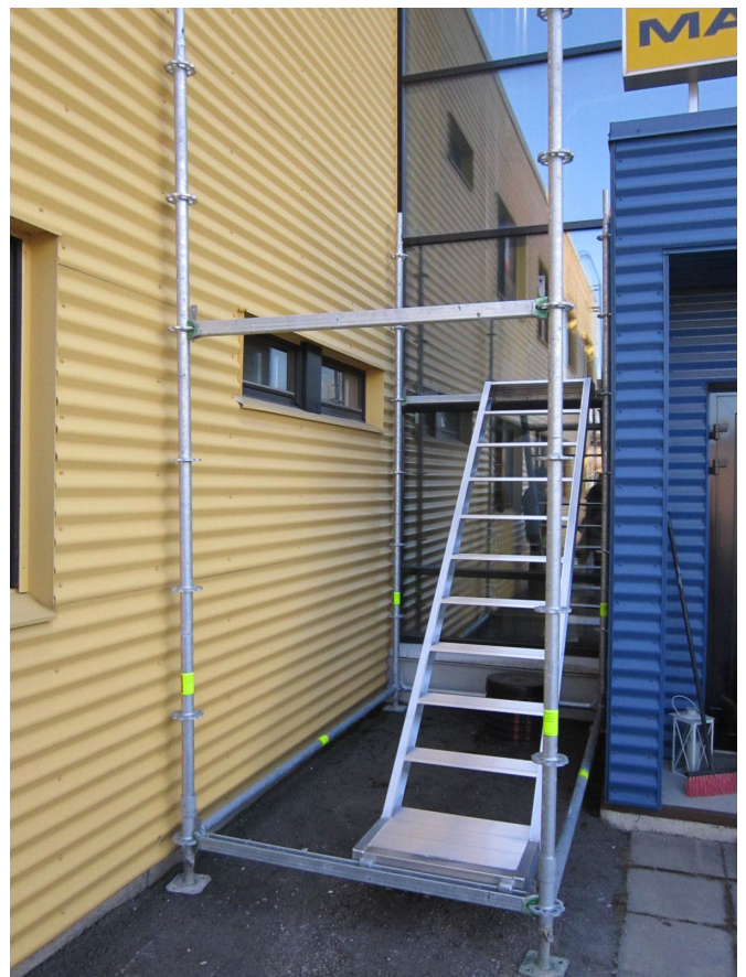
4. Kakkostason U-jokkien asennus, jonka jälkeen on mahdollista laittaa ensimmäinen porraskäynti paikoilleen.
