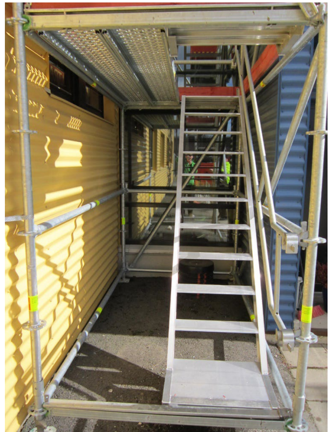
20. Poistumistie sivulle jalkalistojen asennus
