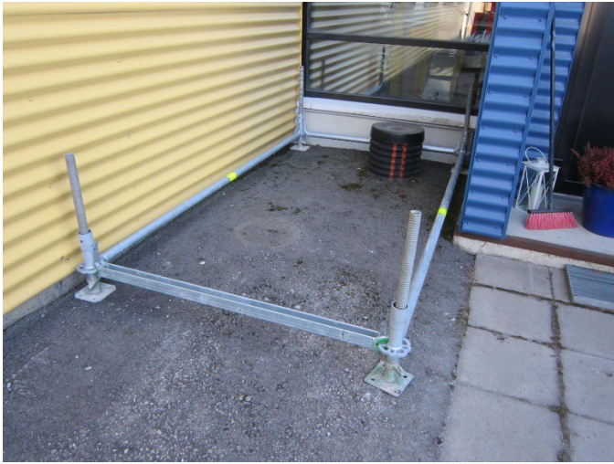
1. Säättöjalat, aloituskappaleet, 2,57m O-vaakajuoksut pitkälle sivulle ja lyhyet 1,4m U-jokat lyhyelle sivulle.
