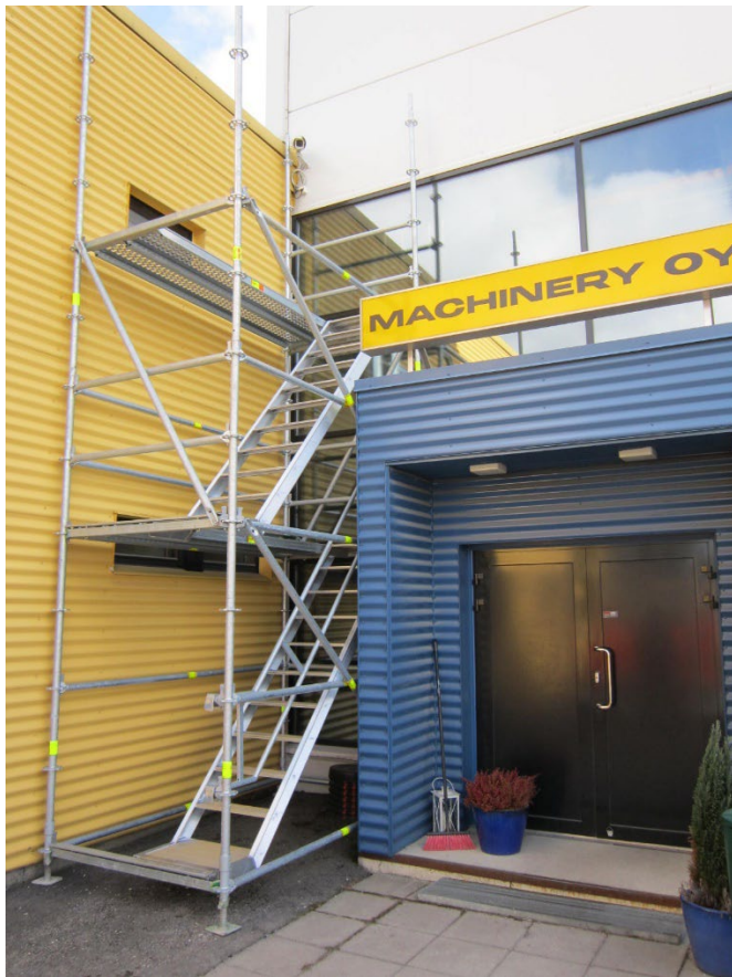
13. Kuvassa voidaan nähdä lyhyiden ja pitkien pystyvinotukien asennus 1. ritilätasolta alkaen. Kuvassa seinän vieressä ei ollut tilaa pystyvintuen asentamiseen. Vinotuki tulee asentaa jokaiseen lohkkoon, jokaiselle lyhyelle ja pitkälle seinälle.
