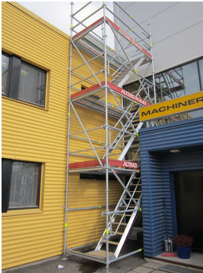
21. Täydellinen porrasmousu teline 6m asti. Teline on kiinnitetty seinään 2m välein. Teline on kiinnitetty seinään molemmista pystyputkista.
