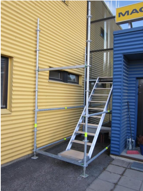
5. Tämän jälkeen asennetaan 1m korkeudelle O-vaakajokat pitkälle sivulle. Pitkät vaakajuoksut asennetaan aina 1,0m välein alimmasta laipasta lähtien.
