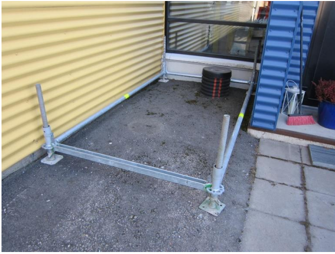
1. Säätojalat, aloituskappaleet, 2,57m O-vaakajuoksut pitkälle sivulle ja lyhyet 1,4m U-jokat lyhyelle sivulle.
