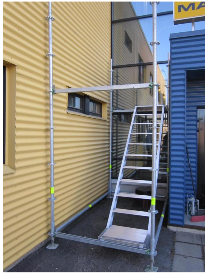
4. Kakkostason U-jokkien asennus, jonka jälkeen on mahdollista laittaa enimmäinen porraskäynti paikoilleen.
