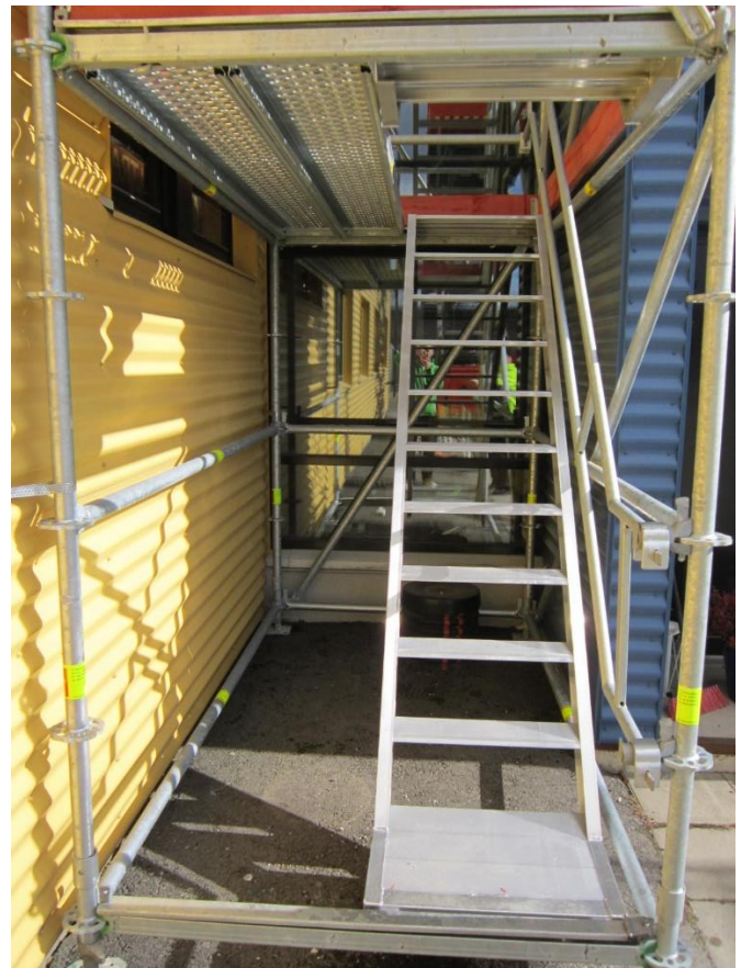
20. Poistumistie sivulle jalkalistojen asennus
