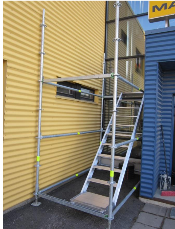
6. Tämän jälkeen 2,0m tasolle voidaan laittaa 2kpl terästasoja U-jokkien varaan.
