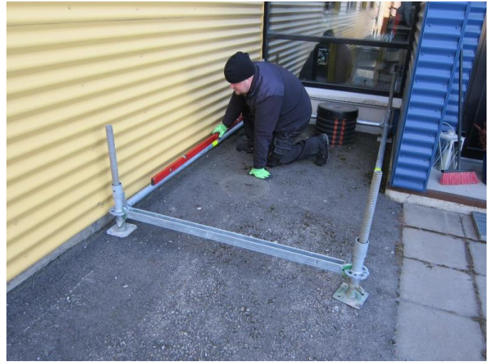
2. Vaaitus vesivaakaa apuna käyttäen.
