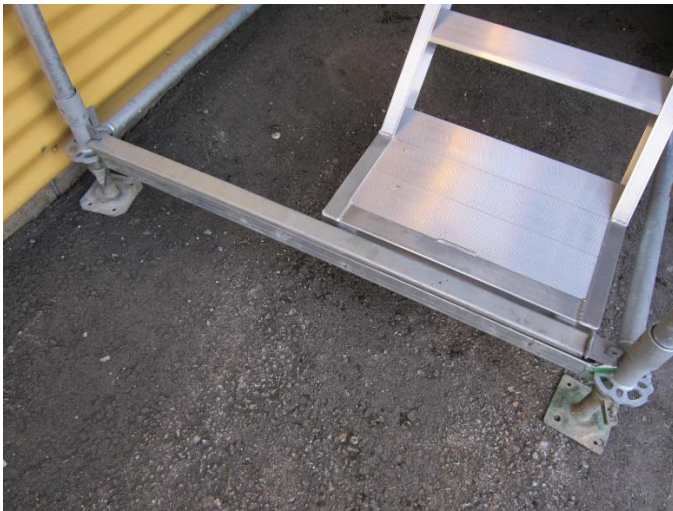
11. Jokaisella tasolla on huolehdittava portaan ja tason kiinnitys tasolukitsimella, jotta taso tai portas ei pääse ponnahtamaan pois paikaltaan.
