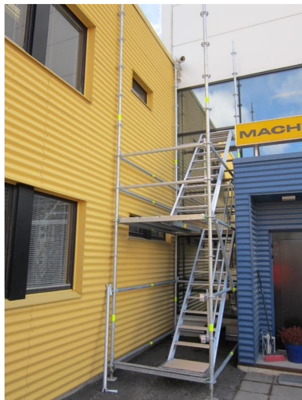
8. Tämän jälkeen ensimmäiselle tasolle voidaan laittaa loput vaadittavat vaakajuoksut ja jokat kaiteiksi. Myös kuvassa on laitettu pitkälle sivulle vinotuki jäykistämään telinettä.
